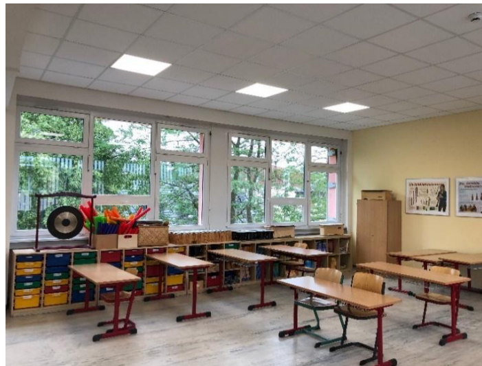
2020 konnte, durch den Förderverein finanziert, eine Akustikdecke mit integrierter Beleuchtung im Musikzimmer installiert werden.
